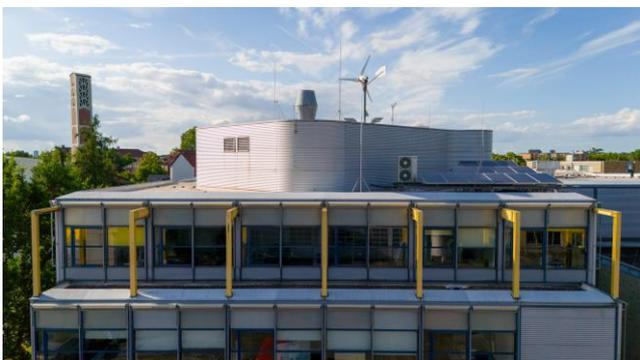
Abbildung 9: Infrastruktur zur Eigenstromversorgung mittels Windkraftanlage und Photovoltaikanlage für die Lernfabrik am IWF der TU Braunschweig (Bildquelle: IWF TU Braunschweig)
